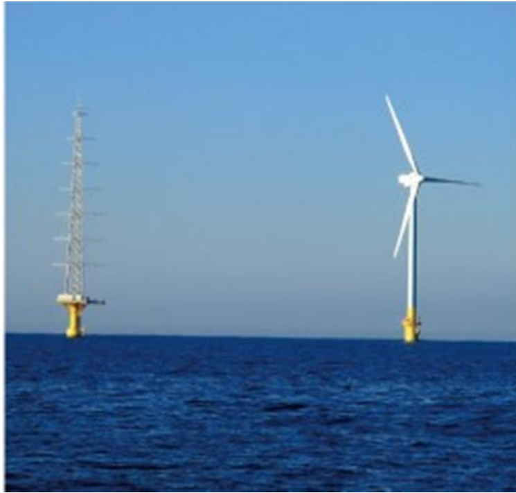
図 1.2 洋上風力発電設備・観測タワー
