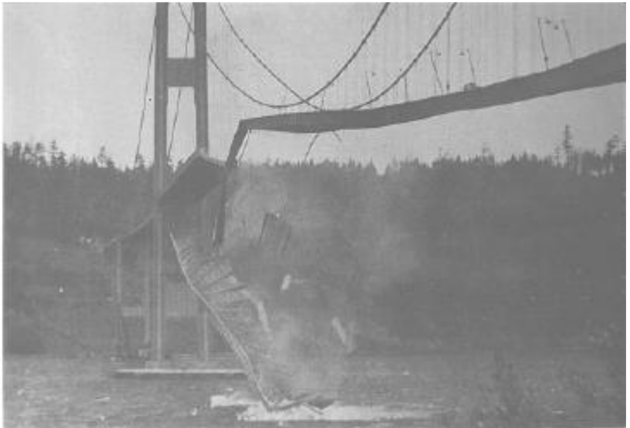
図 1.1 タコマ橋が崩落した様子 (3,4)
